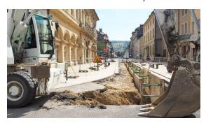
Alimenté à partir de la combustion de déchets, le réseau de chaleur de Pontarlier fournit environ 75 bâtiments en chauffage et eau chaude sanitaire. En tant que propriétaire du réseau, Préval a engagé un programme d'extension pour répondre à la demande et permettre à davantage d'abonnés de profiter de cette énergie produite localement.
